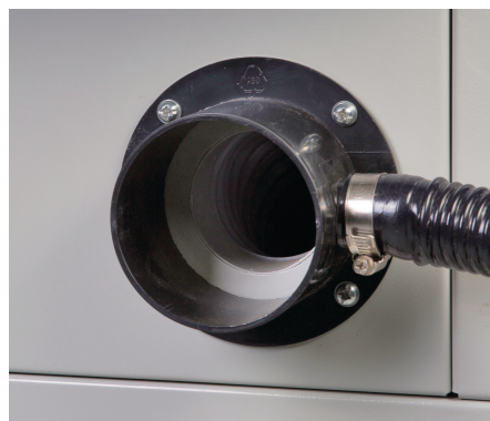
Obr. 23: Montáž přípojky odsávání
