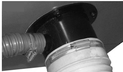
Obr. 27: Montáž odsávacích hadic
