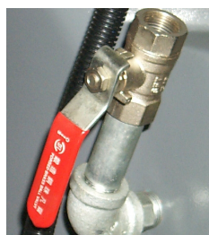
Obr.4-25: Dávkovací kohout
